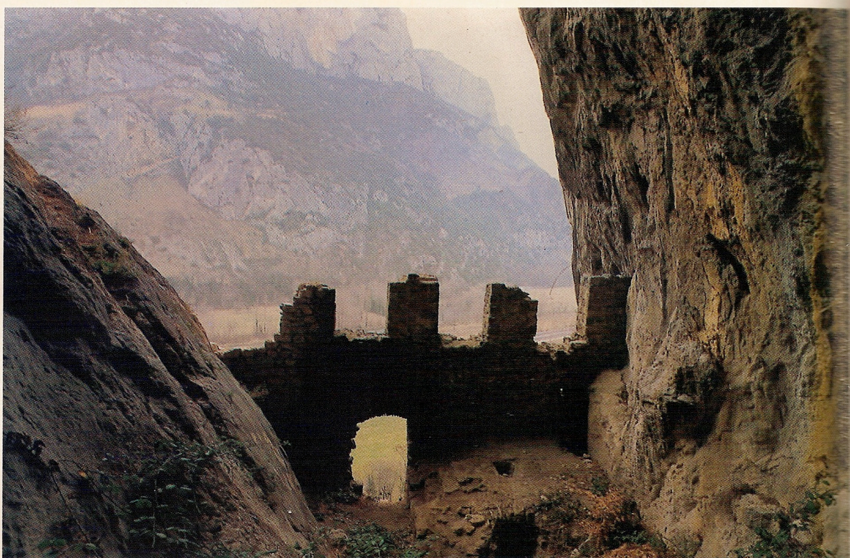
Vue de l'intérieur, la muraille crénelée de la « spoulga » de Bouan.
